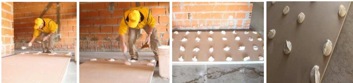
Si los desaplomes de los muros son tales que se requiere espesores de pegamento mayores de 3 cm, se debe tratar el muro antes de instalar, para lo cual se procede con la siguiente alternativa: Con el mismo Adhesivo RS, pegar fajas de placas Durlock hasta mejorar las diferencias de plomo del muro.
